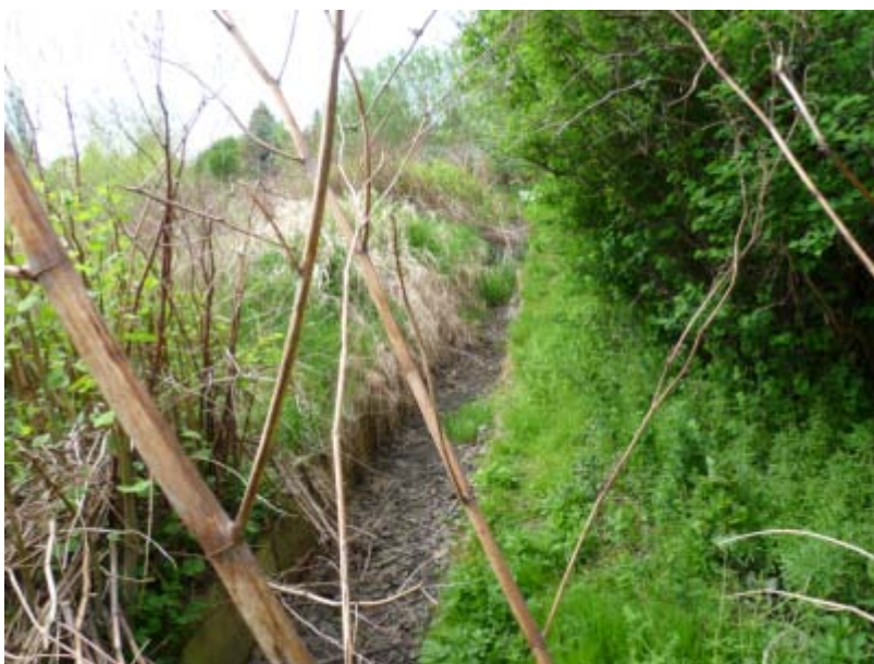
Abbildung 16: Graben R66 unterhalb Verrohrung (westlich der Bahnhofstraße)
