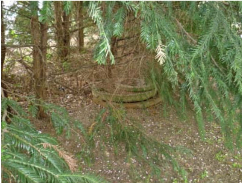
Abbildung 11: Verrohrung im Klinikfreigelände auf Höhe der Sparkasse
