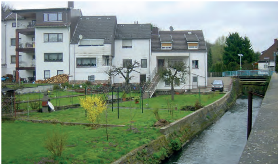
Wohnbebauung am Fischbach im Stadtteil Rußhütte nach dem Starkregenereignis vom 3. Juli 2009 (oben) und im März 2011 (oben: Martin Freitag, Stefan Hank, Saarbrücken)
