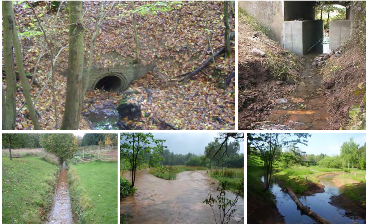
Einige Strategien zur Rückhaltung von Niederschlagswasser: Kleinrückhaltssysteme am Köllerbach (oben); Renaturierung und Schaffung von Retentionsmöglichkeiten in der Aue sowie Verlängerung der Fließgewässerstrecke (unten) (RAG 2012)
